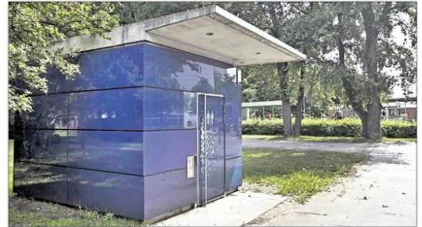
Die Betreiberfirma hat die Außenfront kürzlich mit Platten anstatt mit Glas verkleidet. Steiner
